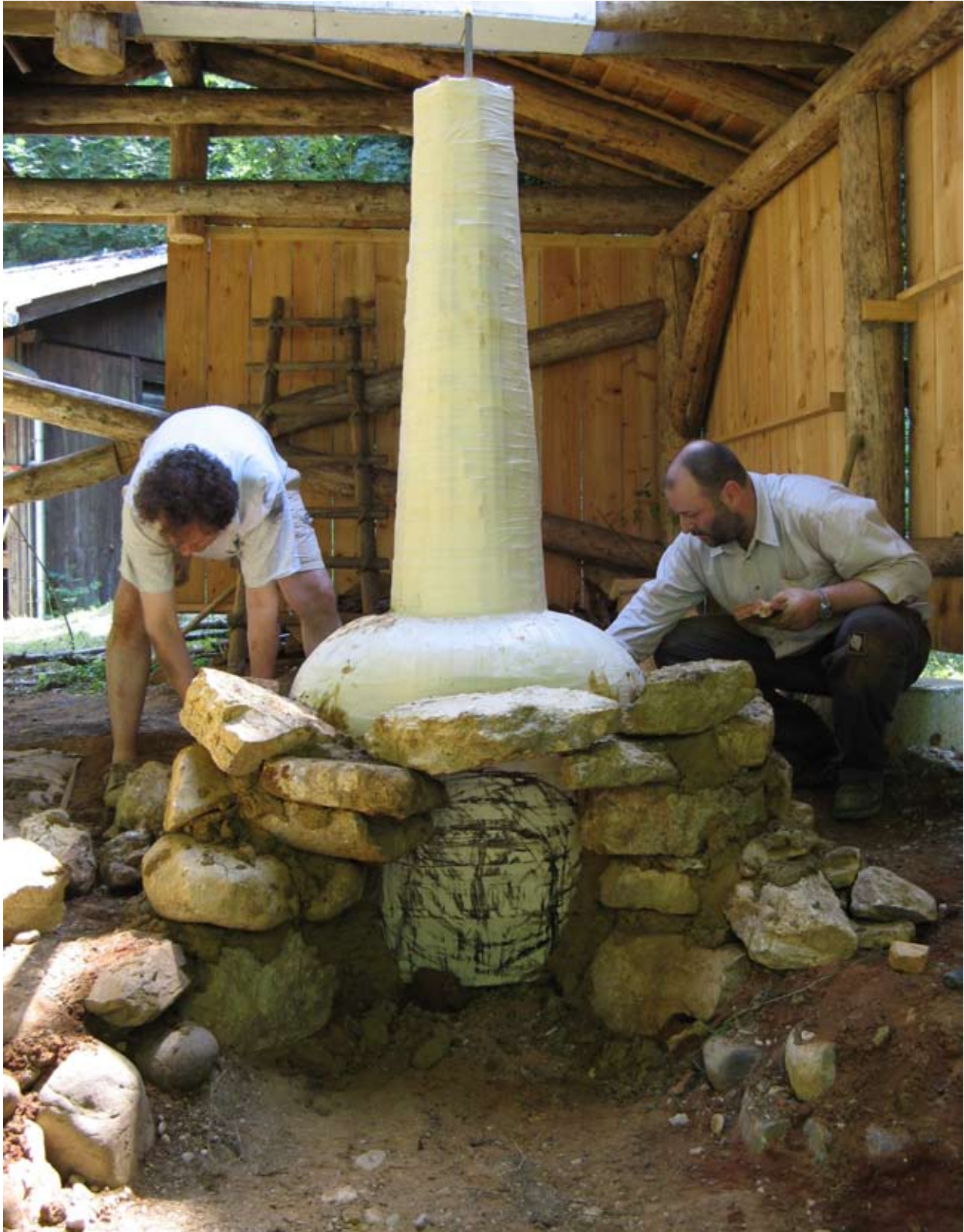
Neubau des Rennofens 2009
