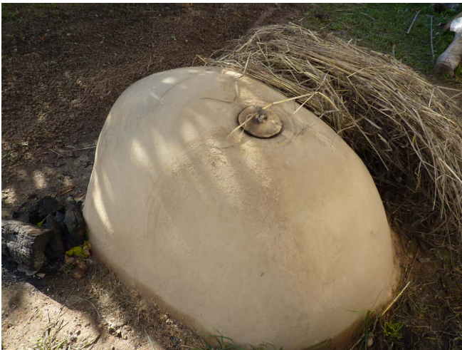
Abb. 15 Der immer wieder ausgebesserte Lehmofen zeigt unten ringsum deutliche Feuchtigkeitsspuren.
