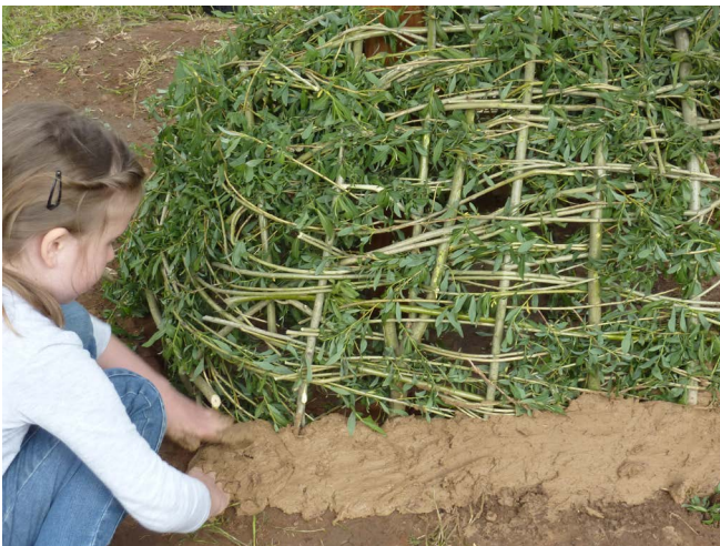
Abb. 9 Nach dem Verflechten des Grundgerüsts mit dünnen Weidenruten wird die Lehmmasse aufgetragen. (Foto: K. Wolters)
