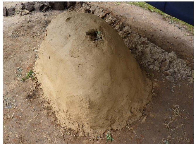
Abb. 10 Noch nicht fertiger Lehmofen, um den eine Abflussrinne gegraben werden musste für das von der Zeltplane abfließende Regenwasser.
