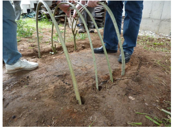
Abb. 8 Das Grundgerüst für den Lehmofen entsteht aus Weidenzweigen. (Foto: K. Wolters)
