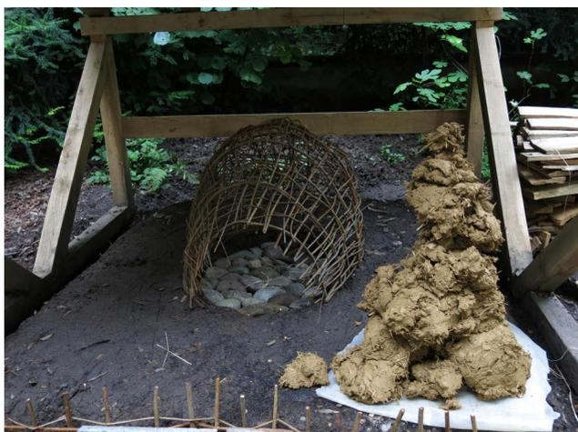
Abb. 8. Das Grundgerüst des Brotbackofens mit Reflektorsteinen und dem aufbereiteten Lehm daneben. (Foto F. Pfenninger)
