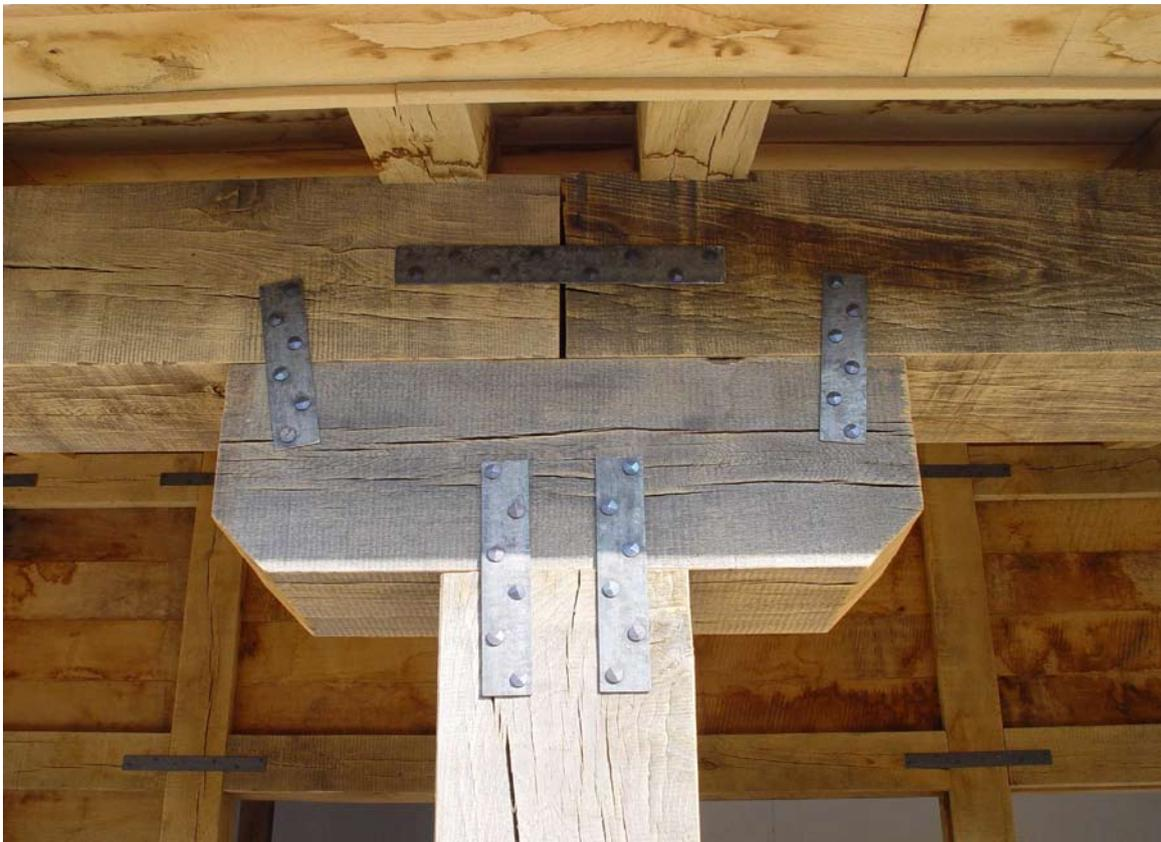
Bild 3: Details der Fachwerkkonstruktion im Bereich der Porticus
