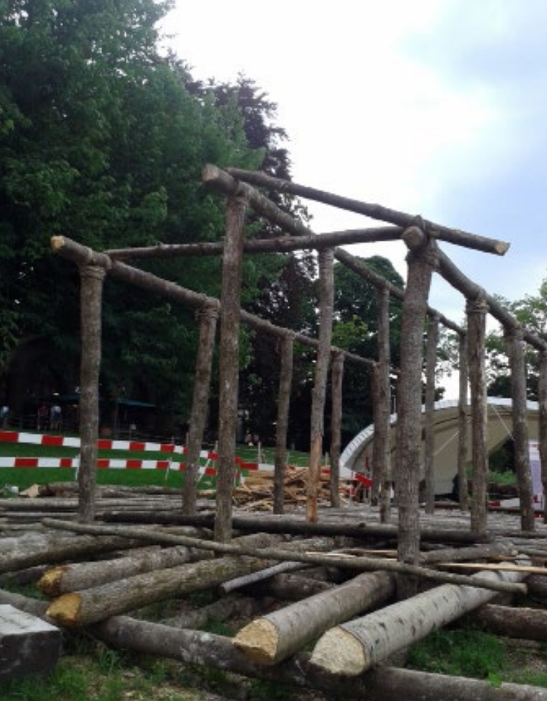
Abb. 5: Schwellhölzer aus Eiche und Esche.
