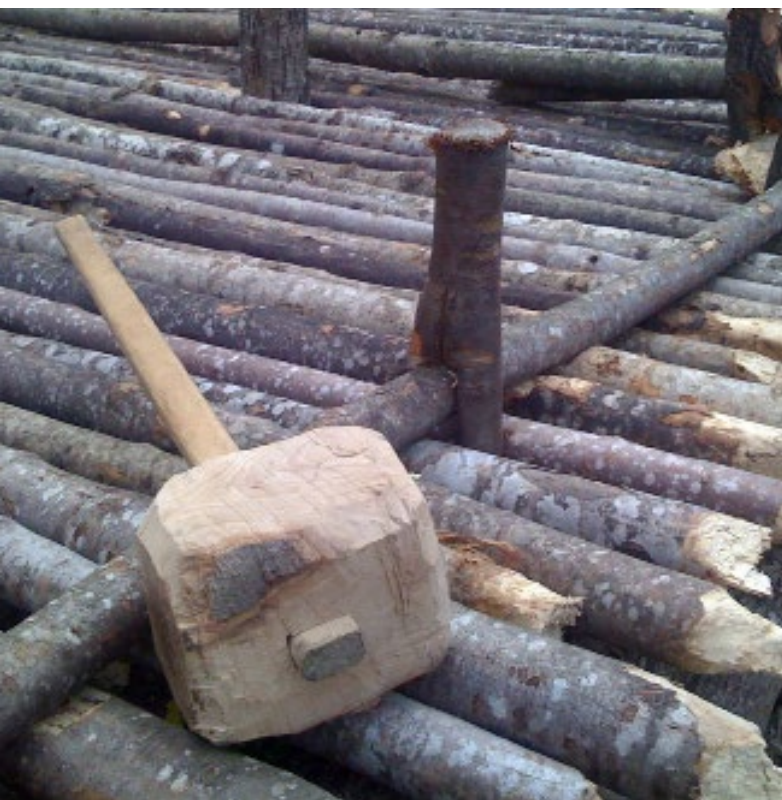
Abb. 6: Seil vermeiden mit Hilfe von Zuglatten und -pflocken.
