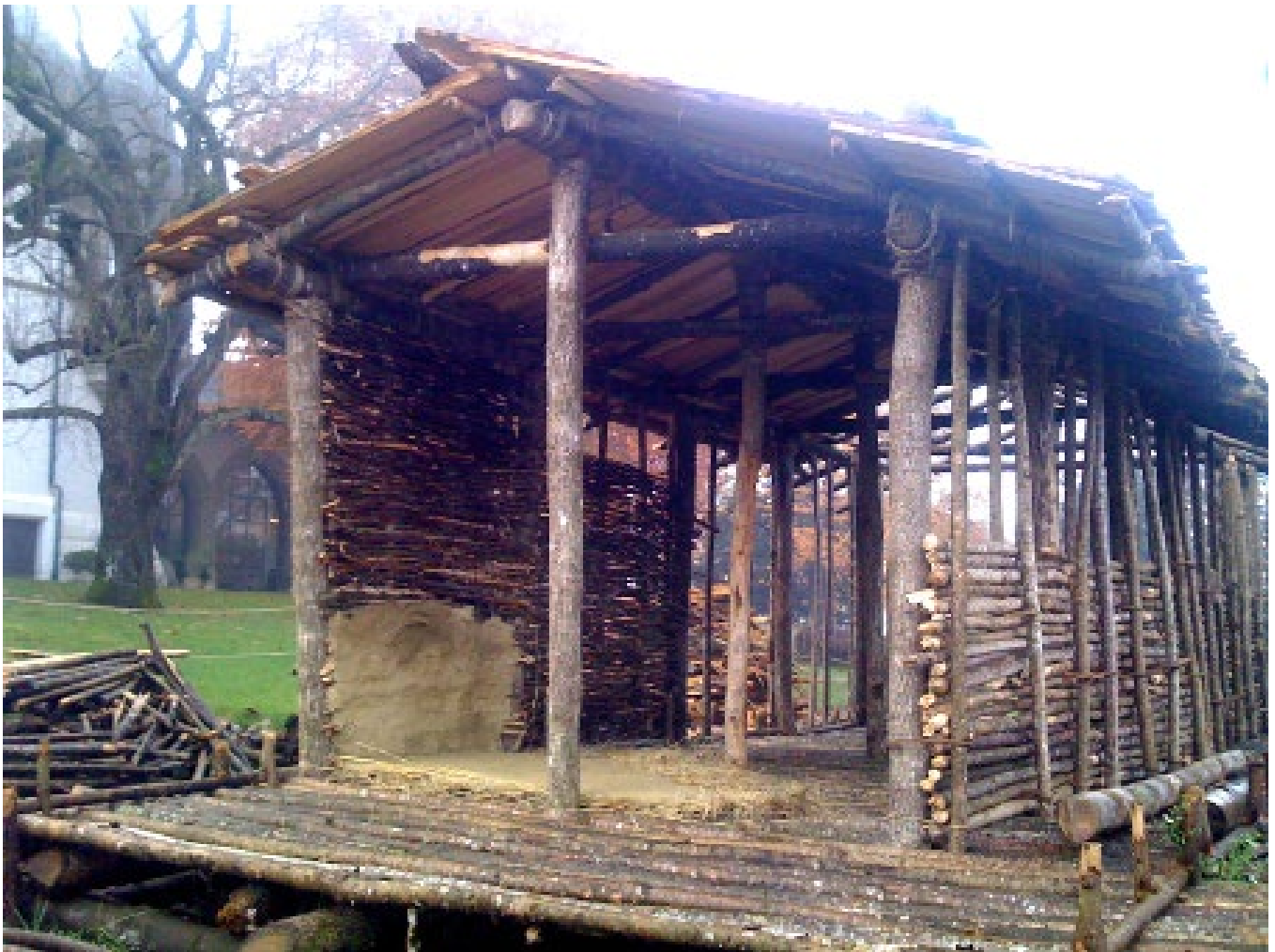
Abb 9: Links die Flechtwand, rechts die Prügelwand.
