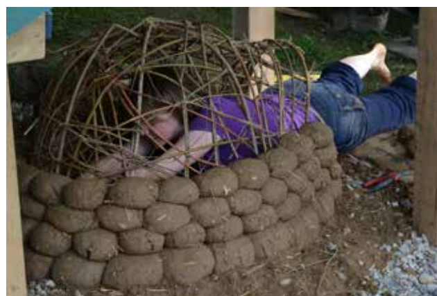
Abb. 3: Das Gerüst aus Weidenruten stützt die Ofenwand aus Lehm, die darauf aufgebaut wird. Bei der ersten Nutzung des Ofens wird das Gerüst herausgebrannt.
